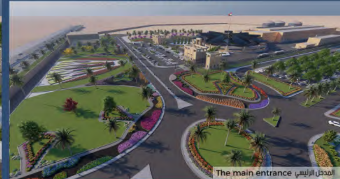
The main entrance المدخل الرئيسي
